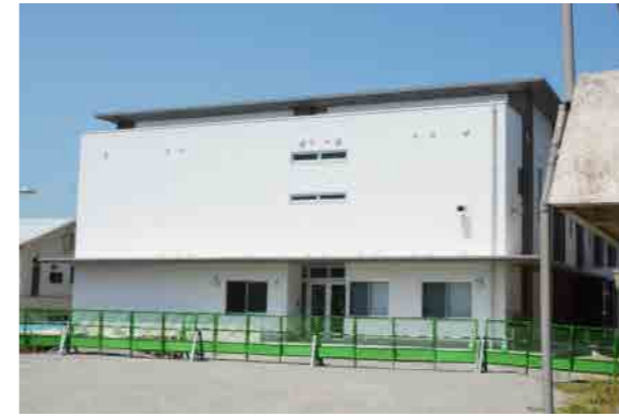
▲建設中の日吉支所新庁舎。中央の扉が入口になります。
