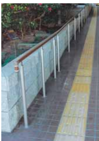
▲スロープに設置された手すり
