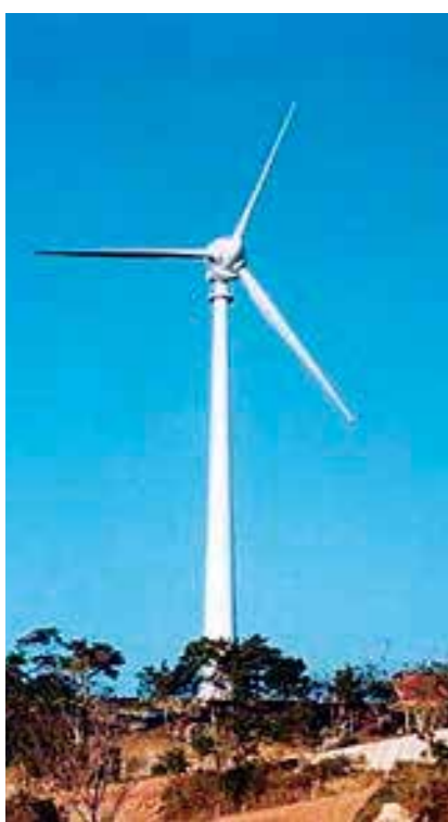
山頂の風力発電所
