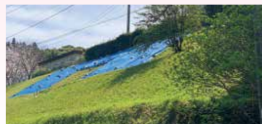
農業構造改善センター法面工事
