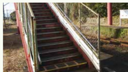
湯之元駅の跨線橋。不自由な階段
