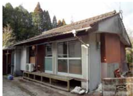
市内にある一軒の空き家
