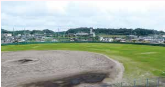
改修工事管理委託・公園施設 長寿命化計画のために
