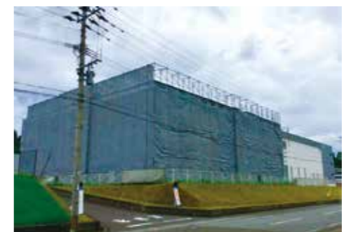
進出企業の増設中の様子
