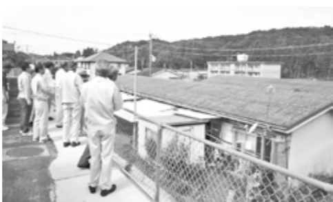
市営八久保住宅調査状況
