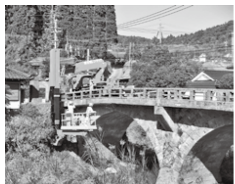
点検中の東市来地域荻前田橋
