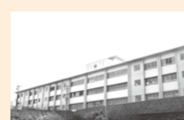
伊集院小学校新校舎
