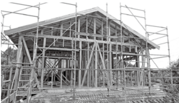
市内周辺部で建設中の住宅
