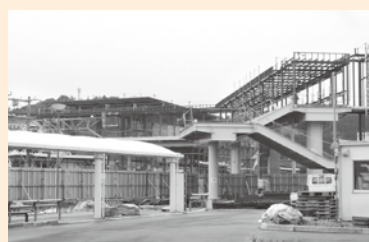
工事が進む伊集院駅
