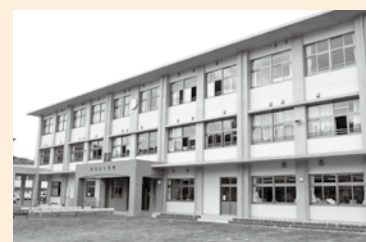
建設された伊集院小学校校舎
