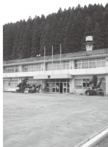
皆田地区公民館として活用されている皆田小学校跡
