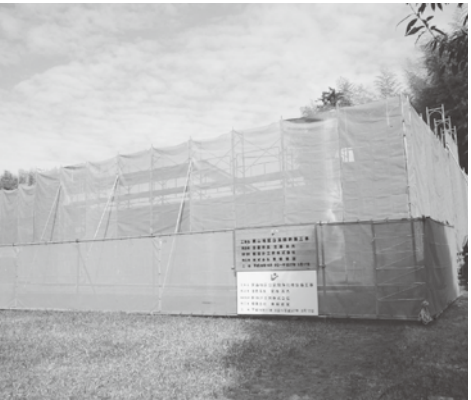
建設中の美山地区公民館
