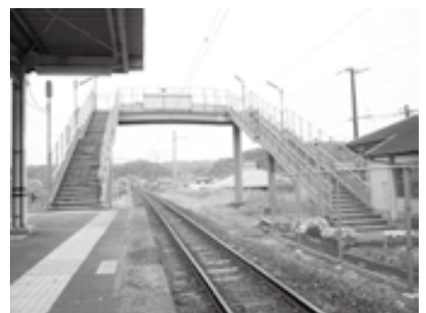
東市来駅の跨線橋
