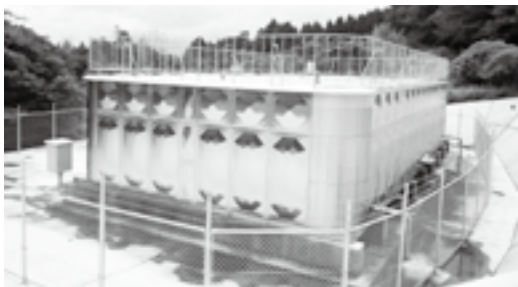
23年度に新設された伊集院北配水池
