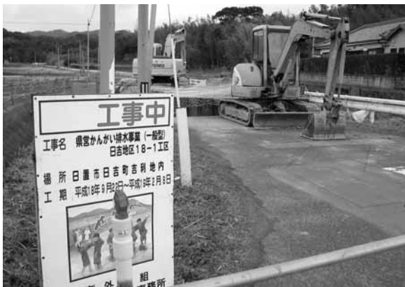
現在工事中の県営かんがい排水事業（日吉地域）
