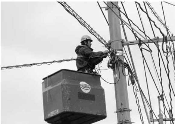
地域イントラネットの工事風景
