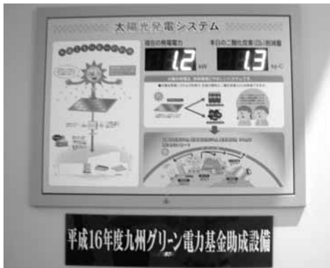
東市来文化交流センターの太陽光発電状況の表示パネル
