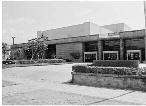
機械室でのアスベスト使用が疑われる伊集院文化会館
