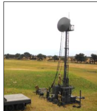
【無線搬送端局（中継）装置1号】
