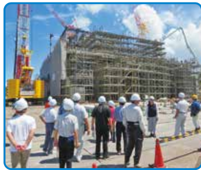
なんさつECOの杜 建設現場の視察
