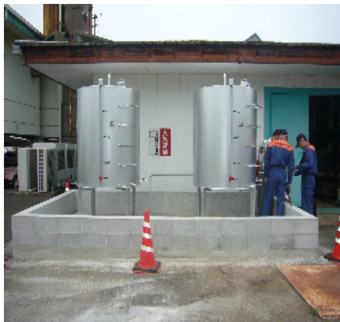
少量危険物貯蔵所条例検査
