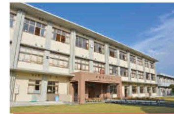
▲伊集院小学校新校舎
