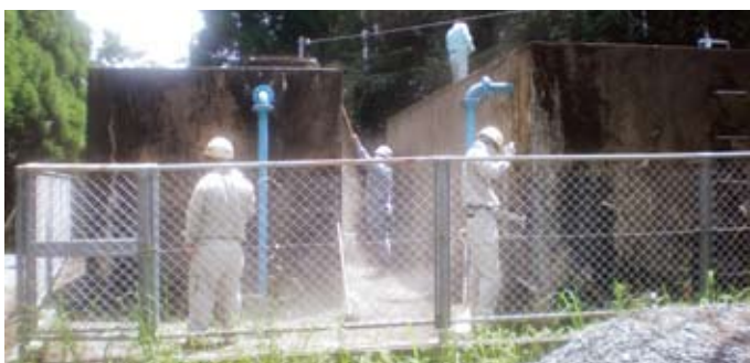
中川水源地での作業 (伊集院地域)
