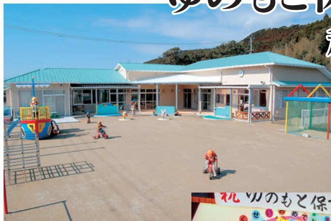
▲完成した園舎
