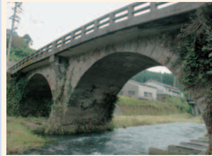
▲貴重な二連式アーチ型石橋「荻前田橋」(昭和6年竣工、長さ21.6m、幅5.4m)
