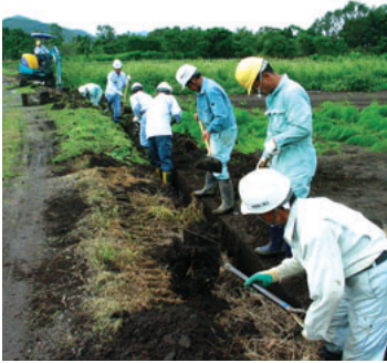
▲土に埋れていた側溝が姿をみせました
