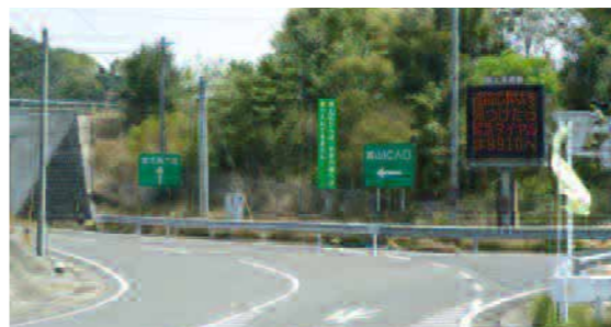
美山インター入口付近
