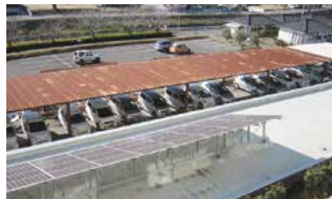
太陽光パネル設置のため
