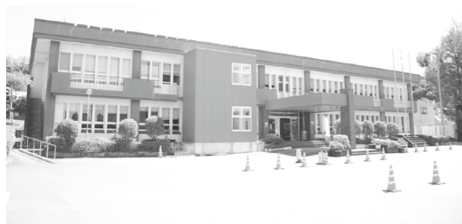
旧耐震基準で建設された指定避難所の吹上中央公民館
