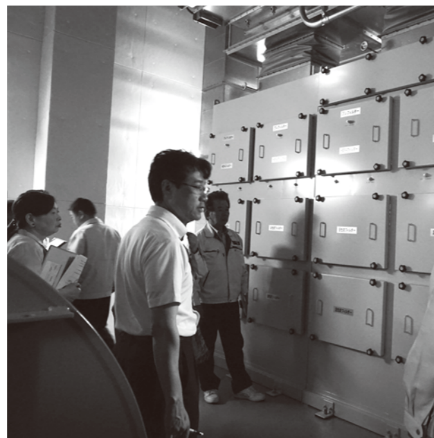
県消防学校内の代替えオフサイトセンター
