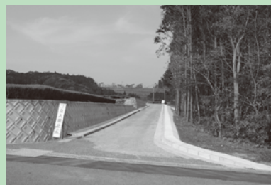
東市来地域の上野地区狭あい道路 の拡幅整備
