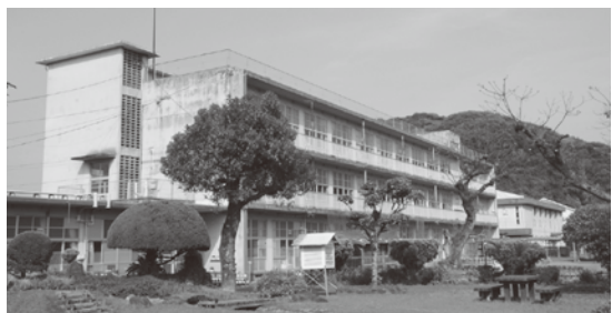
伊集院北小学校校舎
