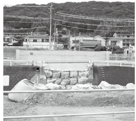
湯之元橋の架け替え工事
