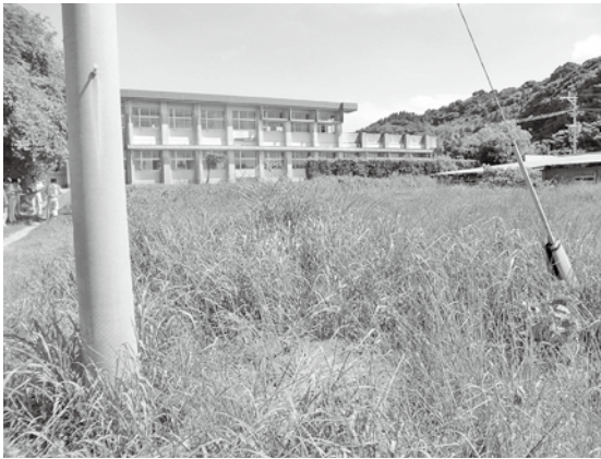
伊作田小学校となりの江口公営住宅予定地
