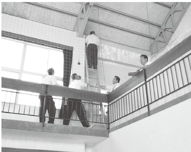
東市来体育館の屋根の状態を調査
