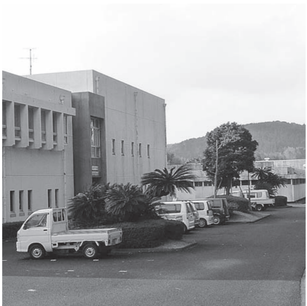
耐震補強が求められる終末処理場
