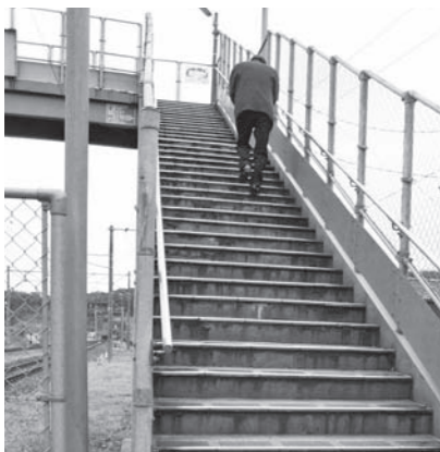
東市来駅の高架橋
