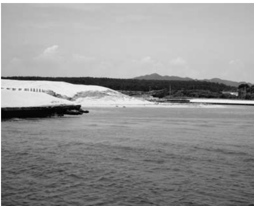
砂が堆積する吹上漁港
