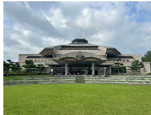
吹上浜公園体育館
