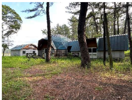
施設内に残る建物
