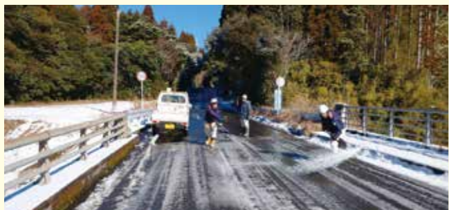
令和5年1月下旬の降雪に対する建設業者の復旧活動
