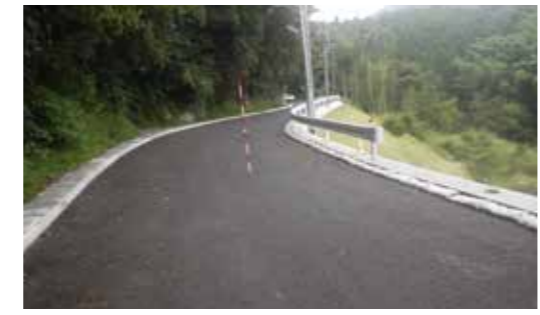
湯之元今木場線の道路改良
